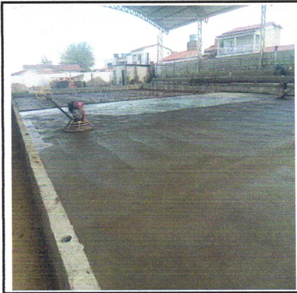
FOTO 16-Polimento de piso cimentado - R1
