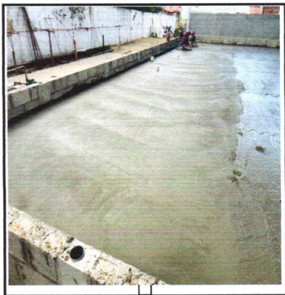
FOTO-13 Polimento de piso cimentado - R1
